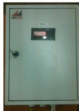
Рисунок 4.4 - Внешний вид электронагревателя с блоком управления
